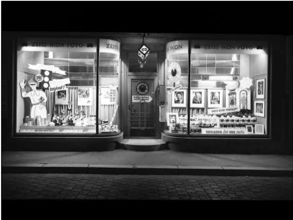
Hafnerstraße 23 Foto Ohle Nach 1950...?
