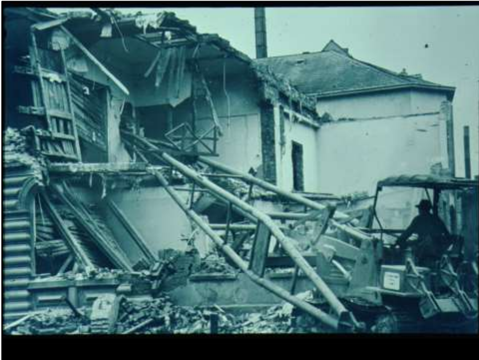
Neue Torstraße 30 Abbruch Fahrradhandlung Deppe
